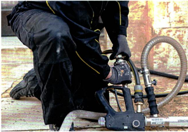
Am Baukompressor liegen drei Schläuche an: für das Strahlmittel (transparent), das Wasser (Mitte) und die Druckluft (schwarz)
