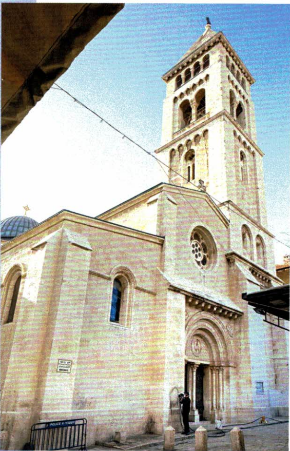
Die Reinigungsarbeiten von Kärcher sind Teil einer umfassenden Gesamtanierung der im neuromantischen Stil erbauten Erlöserkirche
