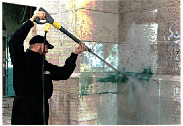
Bei der Reinigung im Vorjahr zeigt sich der Ist-Zustand der Fassade. Damals entfernte Kärcher Salzausblühungen, Stäube und Pilze
