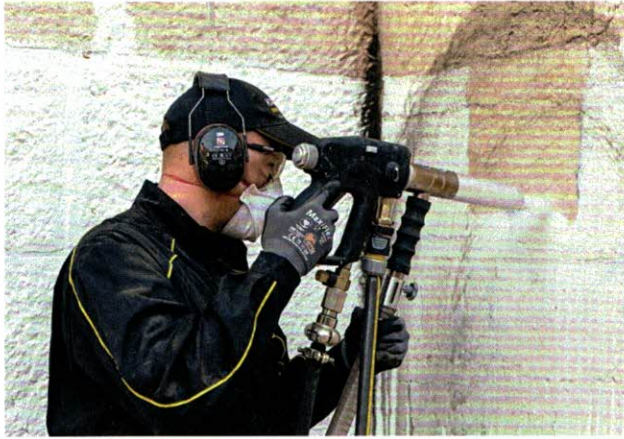
Circa 75 Quadratmeter Kalkstein-Fassade befreit Kärcher via Mikro-partikel-Strahlverfahren mit Aluminiumsilikat von Graffiti und Farbe
